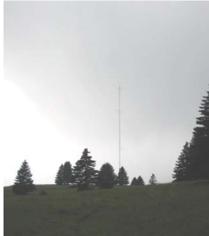
50 m environ: c'est la hauteur atteinte par le mât de mesure du vent (voir en comparaison la taille des sapins).
