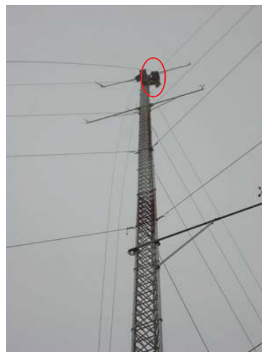
Le dispositif de retour (poulie) doit être fixé en haut du mât. Il faut donc quand même monter ! (Rassurez-vous, votre rédacteur en chef préféré est resté sagement au sol.)
